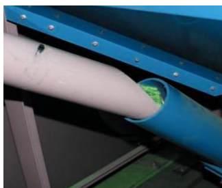
Fot.2. Wyciąganie rury podajnika ze ślimakiem
