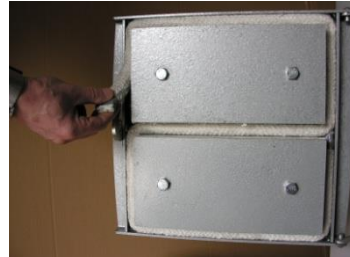
Fot.9. Wymiana uszczelki ceramicznej drzwiczek
